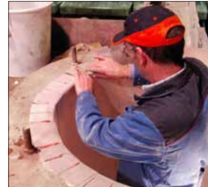
Vor dem Einsetzen des DORIT Fertigiegels werden die Isolierungen und das Tiegelbett eingebracht.
