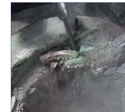
Zunächst wird der obere Tiegelrand mit dem Presslufthammer entfernt.
