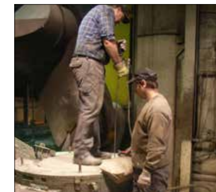
Der Tiegel wird mit Hinterfüllmasse mittels Verdichter-Lanze fixiert.
